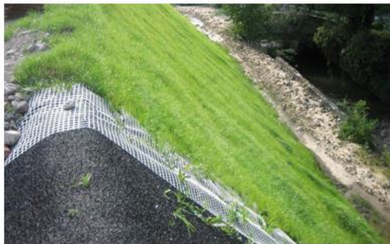
Рис. 7. Укрепление склона травянистой дернообразующей растительностью
