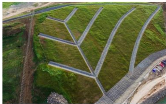
Рис. 8. Осушение оползневого склона
